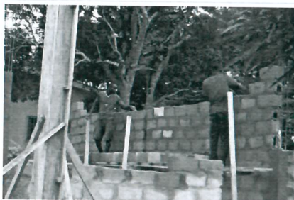
I lavori di costruzione dell'istituto "Saint Jean"
