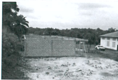
I lavori di costruzione dell'istituto "Saint Jean"
